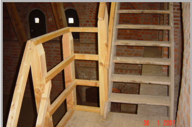
Vorschriftsmäßig gesicherter Treppenaufgang
