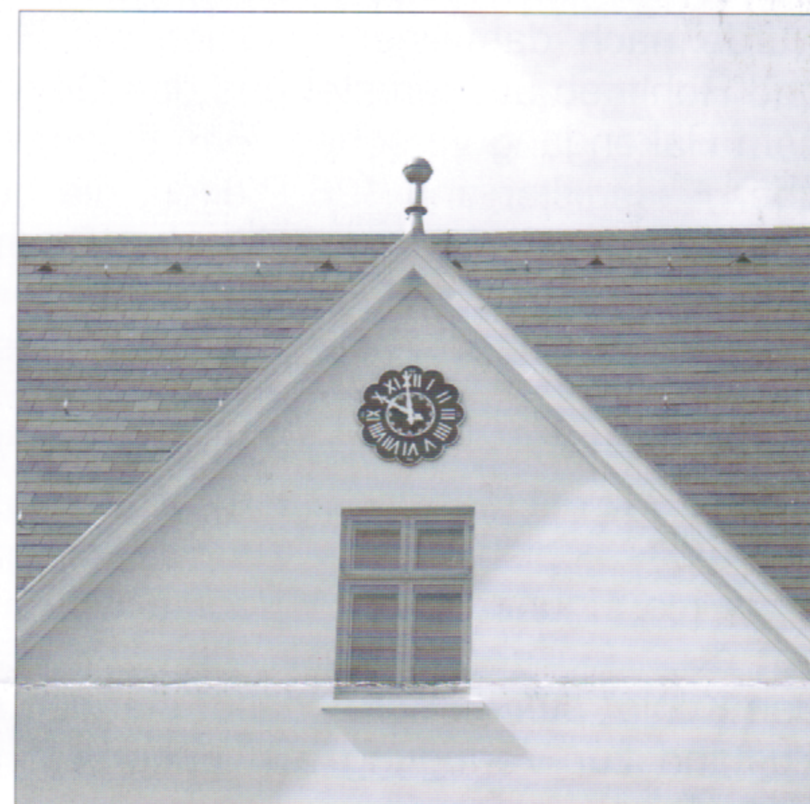
Die Turmuhrfabrik Rochlitz war bekannt für oft effektvolle Zifferblattgestaltungen. Auch hier trägt die besondere Form des Zifferblattes viel zum stilvollen Aussehen des Gebäudes bei.
