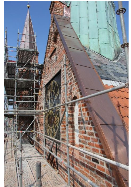
Restaurierung vom Gerüst
